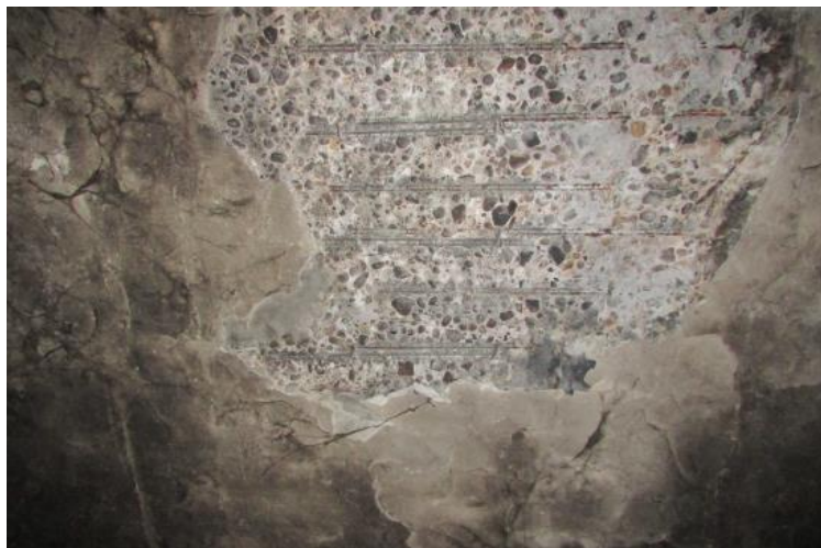
Figura 9. Detalhe área de armaduras expostas e destacamento de concreto na face inferior da laje.
