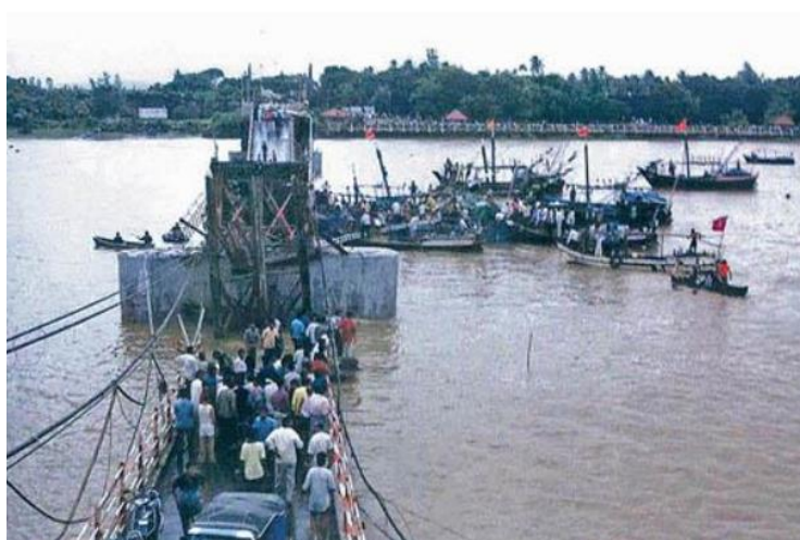
Figura 2. Colapso da ponte Daman na Índia.
