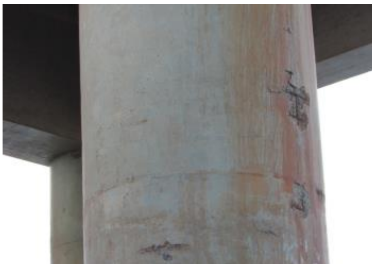
Figura 8. Detalhe de área de armaduras expostas em pilar.
