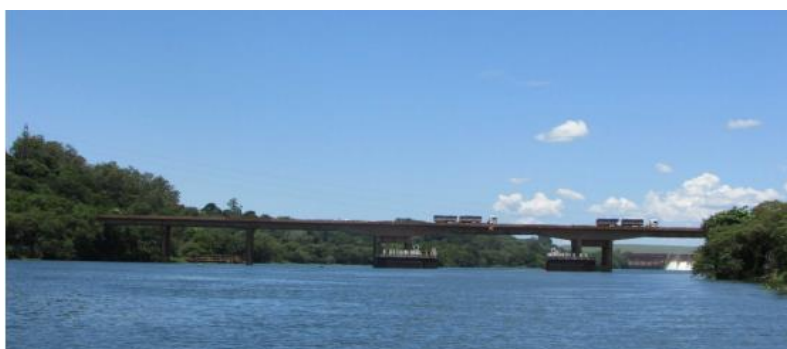
Figura 3. Vista lateral da Ponte do Açúcar.
