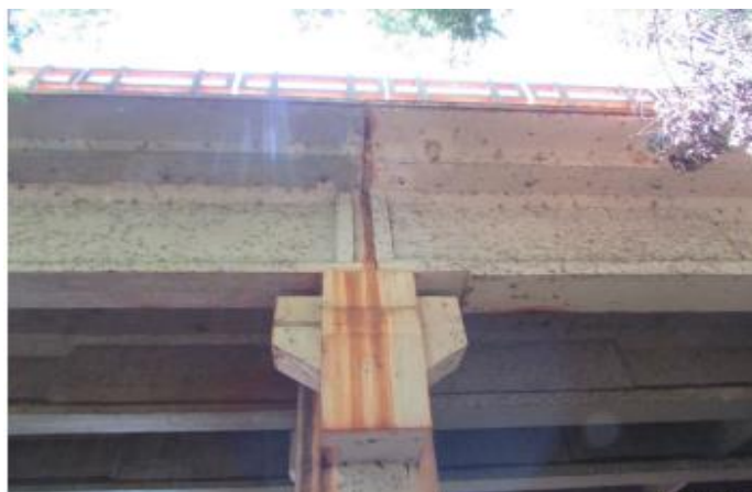
Figura 11. Detalhe de percolação de água sobre as vigas travamento e pilares.
