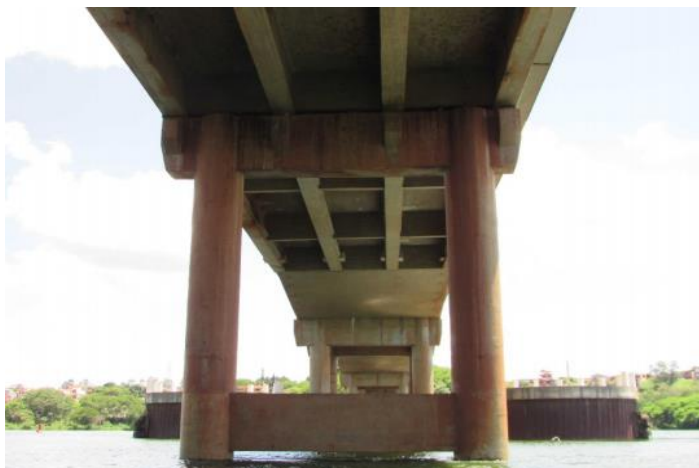
Figura 5. Vista inferior da Ponte do Açúcar.
